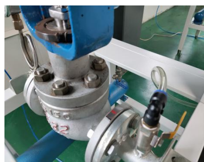
图四 实训装置管路部分
